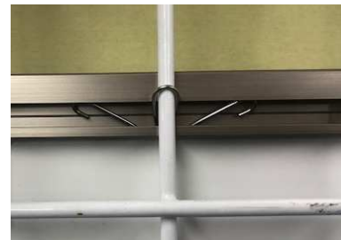
バネ材取付完了
